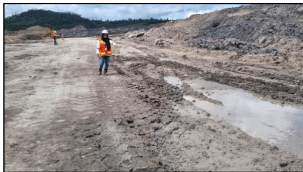
Gambar 2. Ketidaksempurnaan saluran drainase
