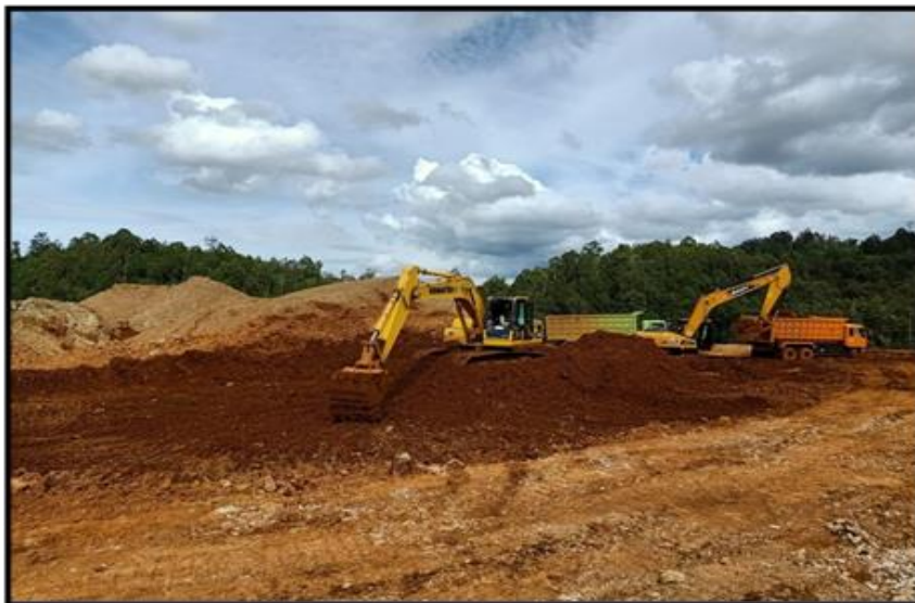
Gambar 4. Pengerukan Lantai Dasar Stockpile
