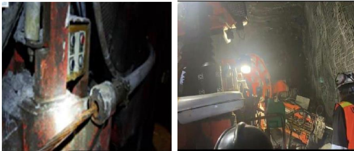
Gambar 2. Tahap Pemasangan Baut Kabel
