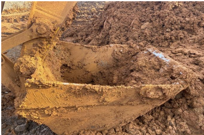
Gambar 4. Material yang melengket di bucket excavator .
